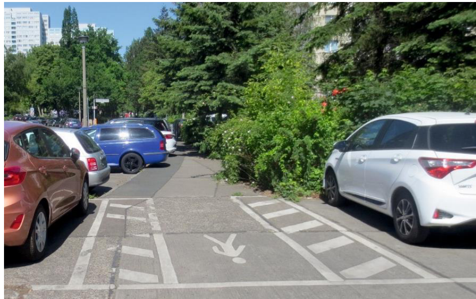
Abbildung 83: Gehweg am östlichen Ende der Hanns-Eisler-Straße
