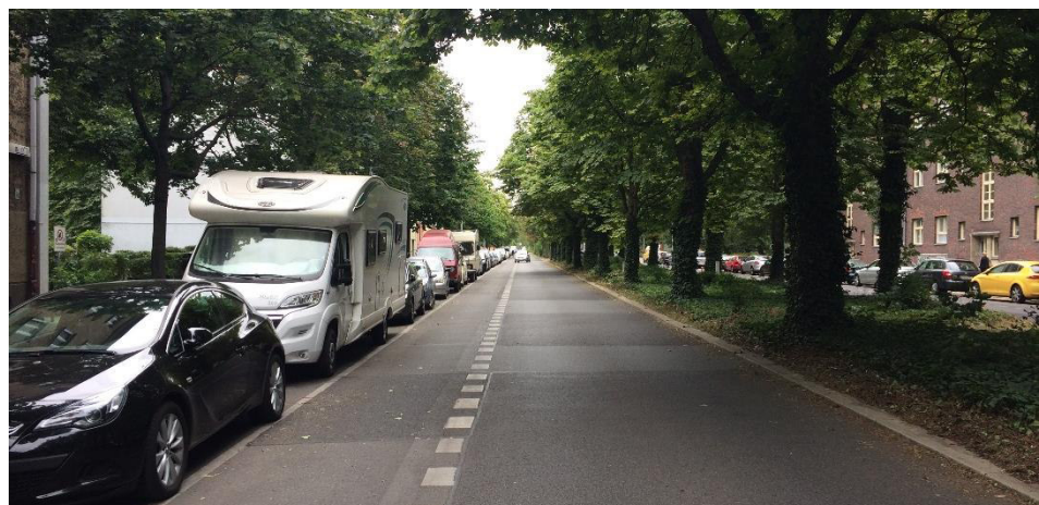
Abbildung 28: Räumliche Nähe der Radverkehrsanlage zu den Kfz-Parkständen auf der Storkower Straße mit fehlenden Sicherheitsräumen zwischen Radverkehrsanlage und Parkstreifen
