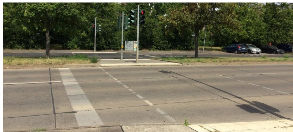
Abbildung 19: LSA mit Elementen zur Unterstützung mobilitätseingeschränkter Personen in der Michelangelostraße
