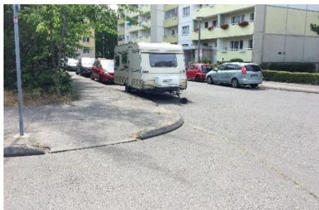
Abbildung 21: Abgesenkter Bordstein ohne taktile Elemente am Beispiel Hanns-Eisler-Straße 50
